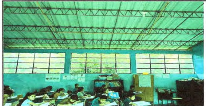
Foto 4. Módulo 4: Sustitución de estructura metálica a costaneras, láminas troqueladas a troqueladas. Sustitución de vidrios de ventanas, pintada de pared interior y exterior.
