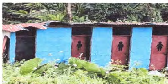
Foto 6: Sustitución de láminas acanaladas láminas a troqueladas. Sustitución de puertas de metal, pintadas interior y exterior.
