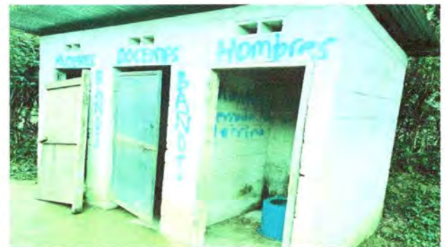
Foto 6: Sustitución de láminas acanaladas láminas a troqueladas y estructura portante. Sustitución de puertas a puerta de metal, pintada de pared interior y exterior.
