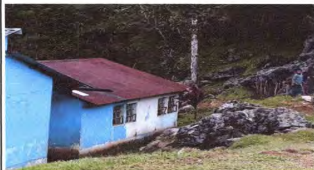
Foto 2. Cambio de piso de torta de cemento a torta de cemento, pintadas de interior y exterior, cambio de estructura de madera a metal, láminas acanaladas a troqueladas.
