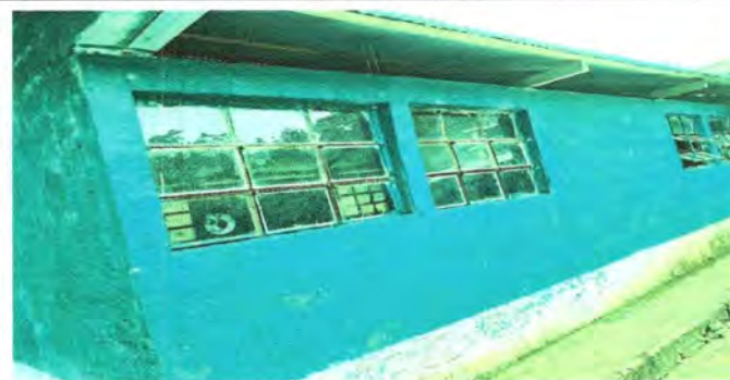
Foto 5: Módulo 5: Sustitución de estructura de madera a costanera, láminas acanaladas láminas a troqueladas. Rehabilitación de balcones, pintada de pared interior y exterior.
